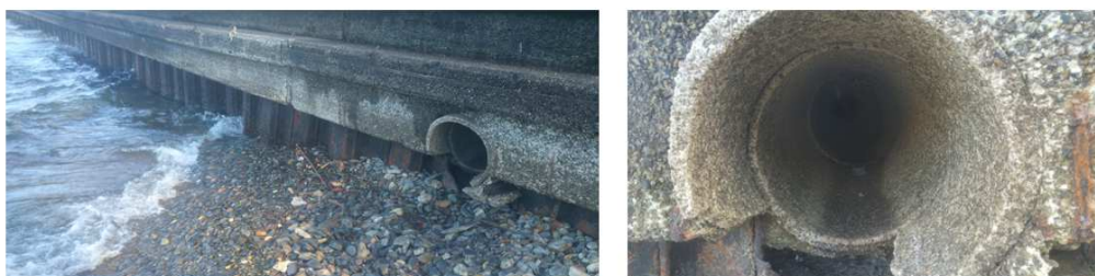
Figura 7 - Esempio di scolmatore a Lago (inizio di viale Dante Alighieri)
