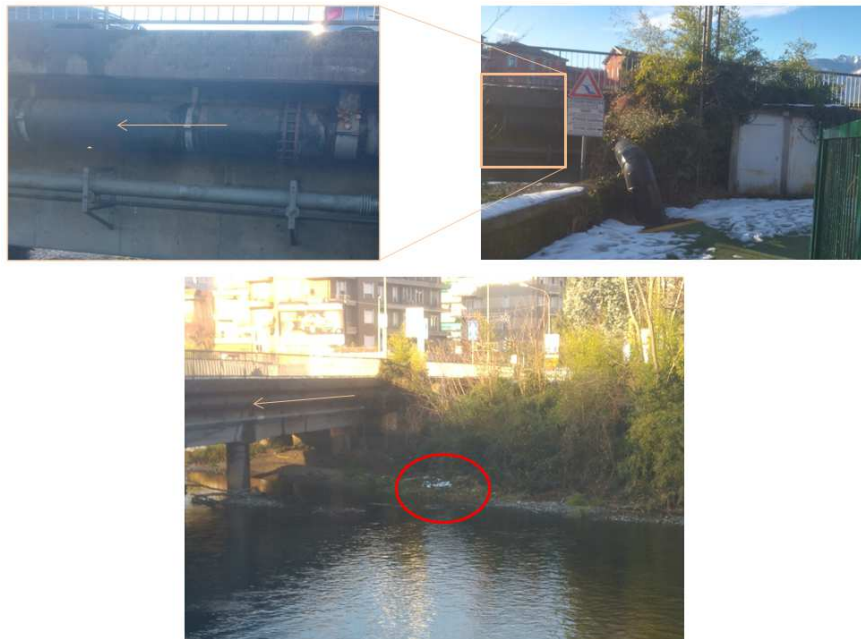
Figura 8 - Stazione di sollevamento Viale Dante Alighieri ang. via Don Piero Folli
