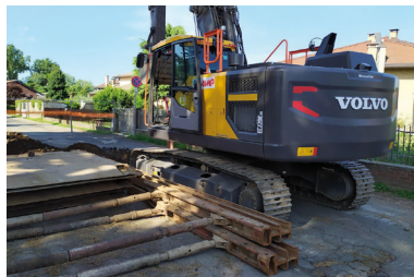
Lavori ampliamento rete fognaria via Ferno e via dell'Usignolo
